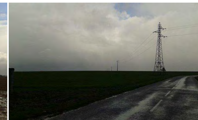
Photographie 9. Ligne électrique proche de l'éolienne E8
